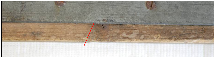
Fig. 153 : Patin en bois en cours de nettoyage.
