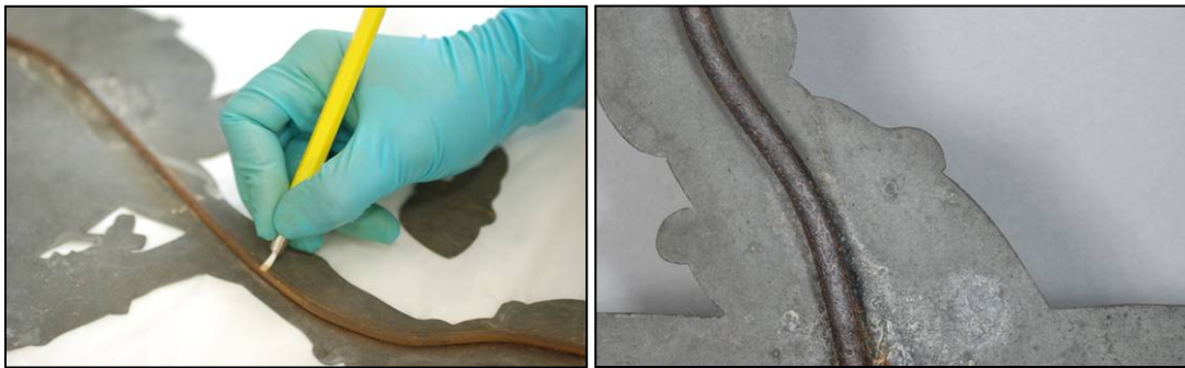
Fig. 147 : Nettoyage des produits de corrosion du fer, en cours et après traitement des armatures des Quatre cavaliers.
